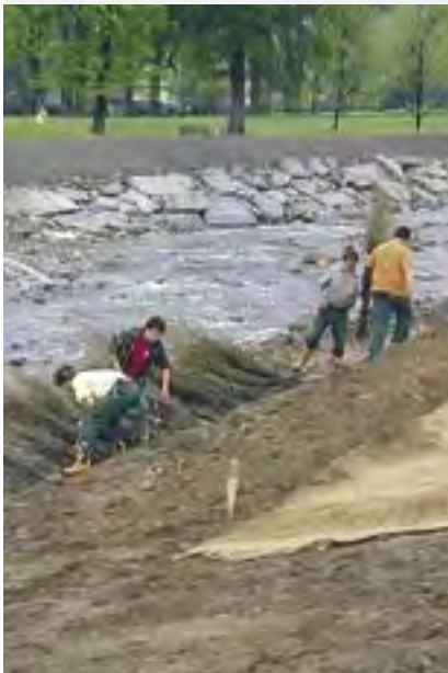
Aménagement de cours d'eau sur la Magliasina (TI) à l'aide du génie biologique.
