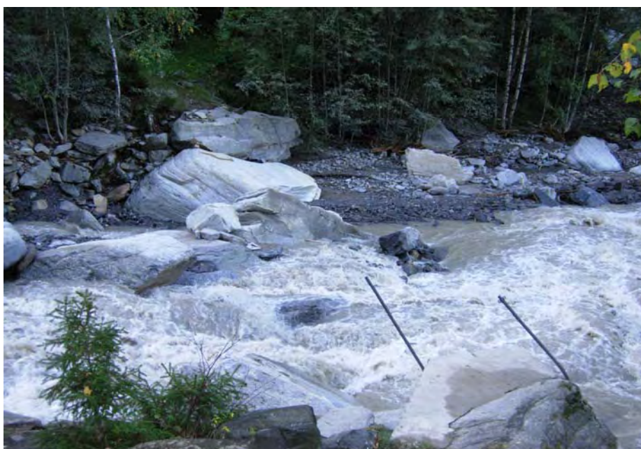
Danni passerella Pontirone
